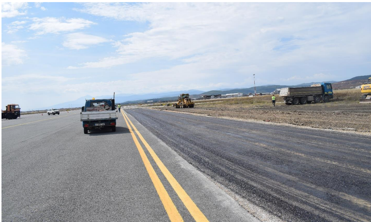
Pamje nga inspektimi i punimeve të projektit për asfaltimin e krahëve të rrugëve për lëvizjen e aeroplanëve në tokë
